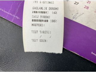
Elektrik donanımı/Pano, Akü > Test Sonucu
