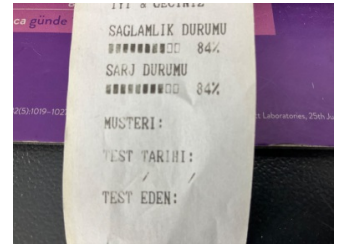
Elektrik donanımı/Pano, Akü > Test Sonucu
