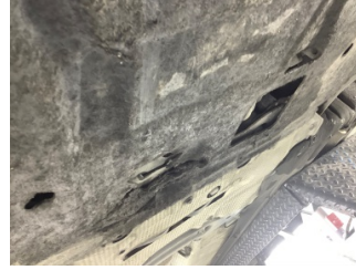
Motor, Alt muhafaza > Hasarlı
