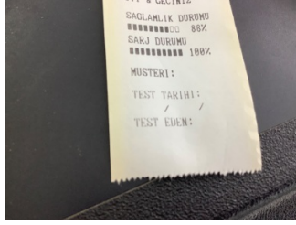
Elektrik donanımı/Pano, Akü > Test Sonucu
